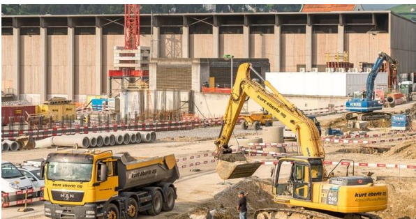
Die minimalen Anpassungen erlauben ein speditives Arbeiten auf den Baustellen.
